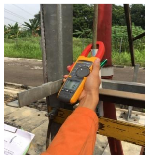
Gambar 3.4. Pelaksanaan Monitoring Arus Bocor pada kondisi beroperasi
